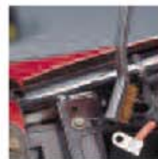
4. De batterijpolen en kabelaansluitingen proper maken.
